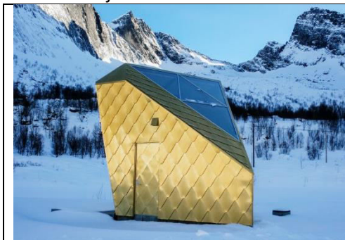
Baños Públicos en metal
