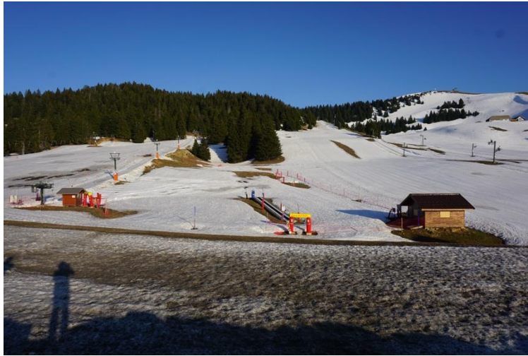
Infraestructura y equipamiento Le Semnoz
