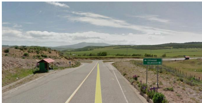
Ilustración 15: Localización Cruce Ruta 7-Balmaceda. Google Earth Pro.
