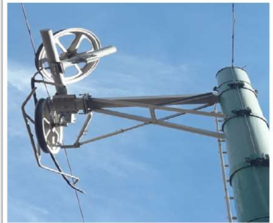
Figura Nro. 1.5 Andariveles Centro de esquí El Fraile. Fuente: propia CAE, para esta consultoría. Marzo de 2018.
