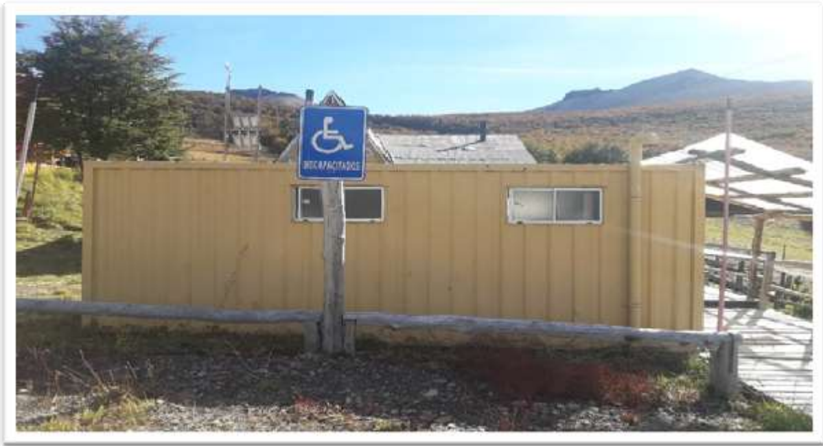
Figura N° 1.6 Infraestructura destinada a Baños. Fuente: Contribución CAE, para esta consultoría, abril de 2018.
